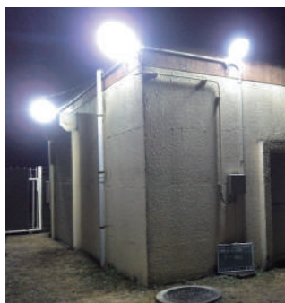
某受水場 防犯灯の設置
