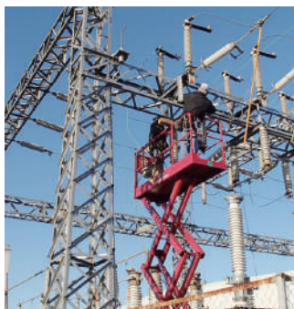
発受変電設備の工事施工
