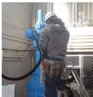
上下水道設備の工事施工
