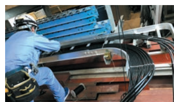
ケーブル布設・結束
