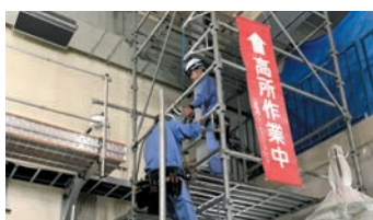
高所作業講習
